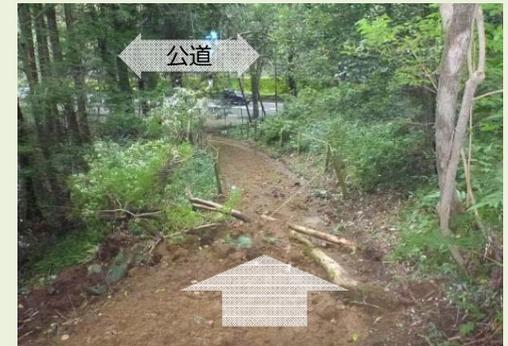
【歩道崩落により流出する土砂】
