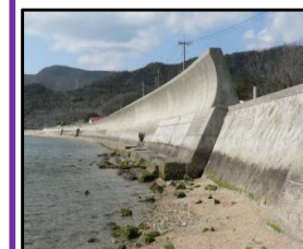
津波、高潮による被害を未然に防ぐため海岸堤防の整備を推進
