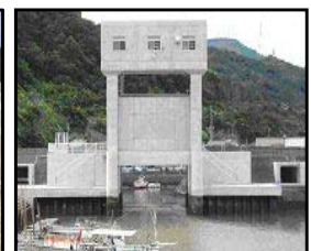
津波・高潮対策としての水門整備
