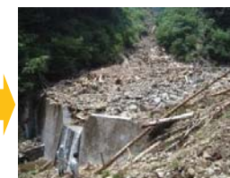
治山施設の設置による土砂・流木の河川への流入の防止
