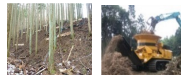
移動抑制対策(筋工)
