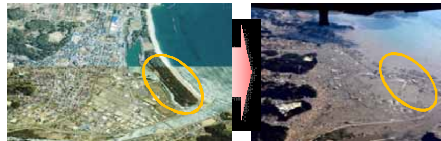
岩手県陸前高田市では、東北地方太平洋沖地震による津波により、海岸林に壊滅的な被害が発生。
