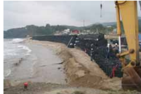
写真：大型土のうによる緊急対策中の防灘護岸工
