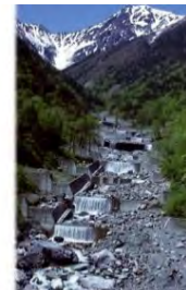
施工後（昭和59年）
