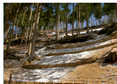
柵工による斜面補強対策
