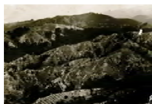
施工後（昭和25年）
