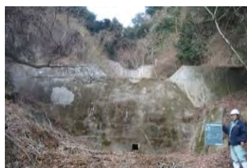
既存ダムをかさ上げ・増厚することにより機能強化・長寿命化（兵庫県神戸市）
