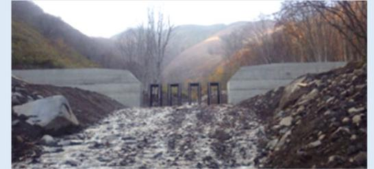
流木捕捉式治山ダムの施工完了後の様子
