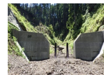
流木捕捉式治山ダム
