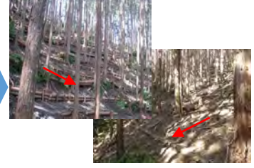
筋工の設置による土壌の保持
