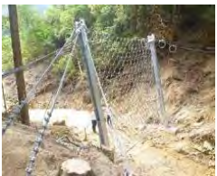
ワイヤーネット工の活用
