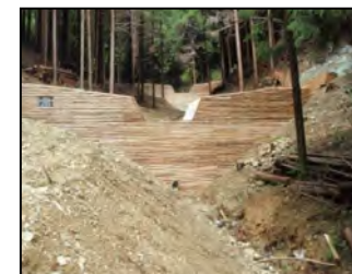
治山ダムの設置状況
