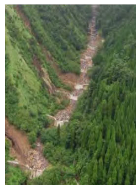
①流下区域における小規模治山ダムの階段状配置
