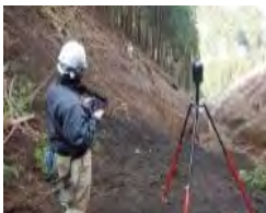
ICT施工の活用
