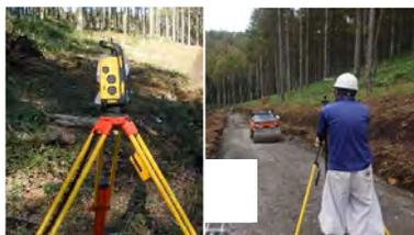
自動追尾型トータルステーションを利用した施工基面の高さ確認状況
