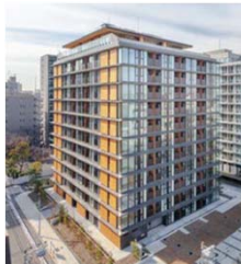
フラットウッズ木場 (東京都江東区) 木造+RC造 12階建て
