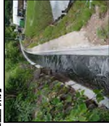
老朽化した用水路の整備・更新
