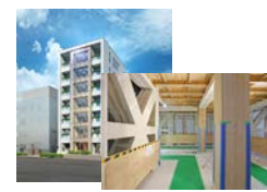
高惣木ビル(宮城県) 主要構造部に製材を活用した木造 7階建てビル(2021年竣工予定)
