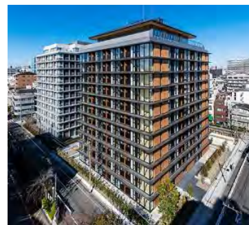
免震構造の木造ハイブリッド建築 （令和2年2月竣工）
