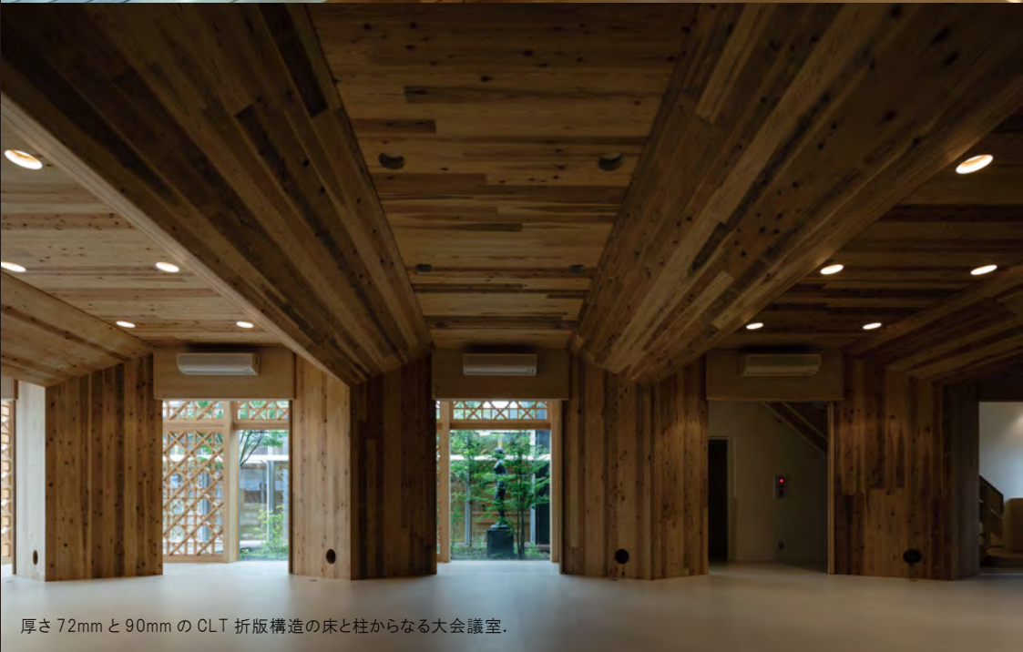
建具工事で制作を行った組子格子耐力壁は壁倍率9倍相当の高耐力を実証実験で確認している。
