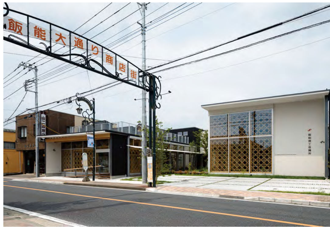
建物南側、大通り飯能商工会議所をみる。
