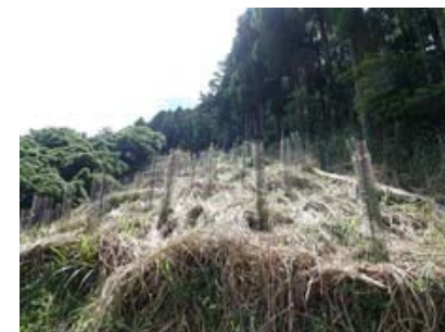
＜保護柵の設置後＞
