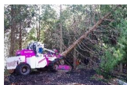
遠隔操作による伐倒作業
