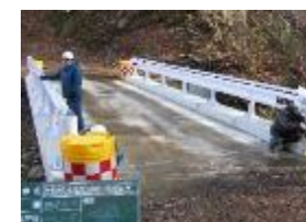
老朽化対策の施工後
