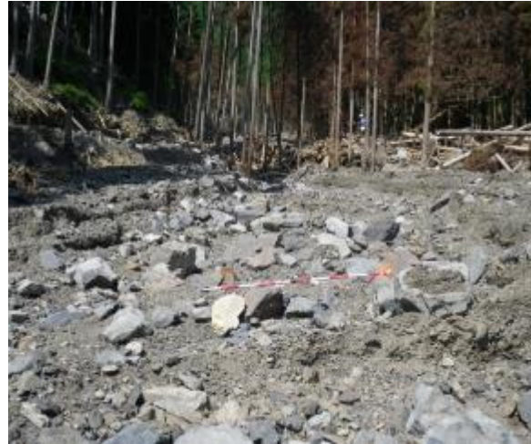
〔治山ダム工(荒廃した溪流を安定化)〕
