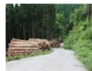
コンクリート路面工
