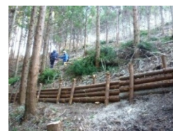
間伐事業地における筋工の設置
