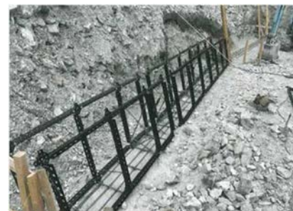
軽量で運搬や施工性に優れた資材による土留工の施工
