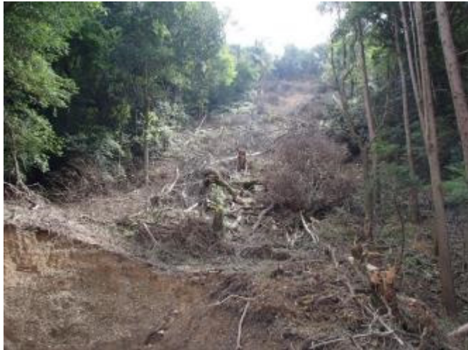
〔山腹工(崩壊した山地を森林に復旧)〕
