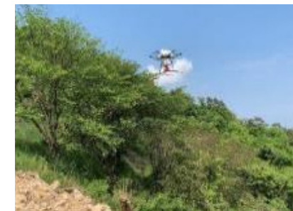
ドローンによる崩壊地の緑化
