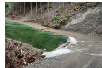
幅員3.5m規模の作業道 「十津川式基幹作業道」
