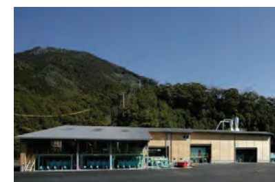
CLT用ラミナ生産製材工場
