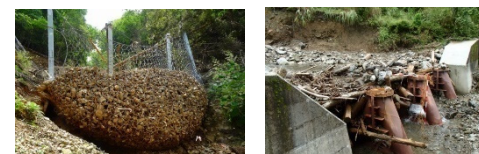
ワイヤーネットやスリットダムによる土石や流木の捕捉
