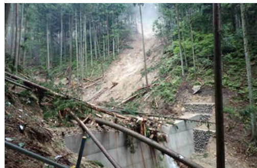
治山ダムが崩壊地から流れ出た土砂や倒木の流出を抑止した事例【岐阜県下呂市】
