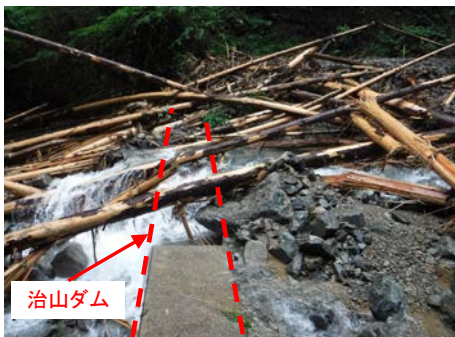
治山ダムが溪流の勾配を緩やかにしていたため流木流出を抑止した事例【福岡県八女市】
