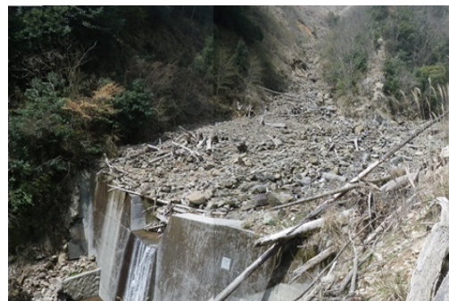
治山ダムが土石流の勢いを軽減した事例【大分県日田市】
