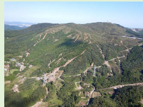
調査で確認された災害箇所
