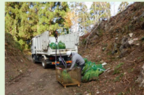
架線による苗木運搬の様子
