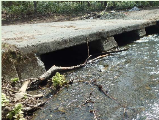
施工前の河床路の様子
