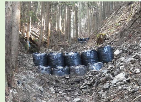
緊急応急対策工事
