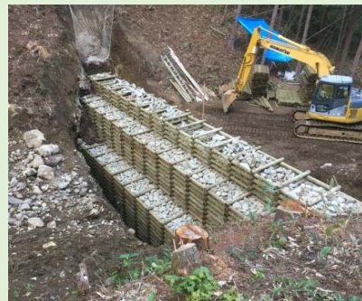
施工中の様子
