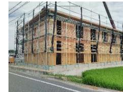
CLTを用いた先駆的な建築物の設計・建築等の実証
