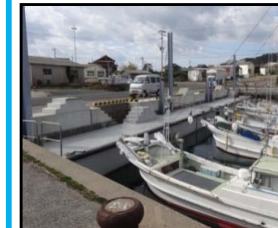
漁業作業の効率化と安全対策のための漁港整備（岸壁改良）
