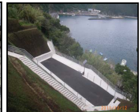
漁村における津波避難対策のための漁港整備（避難地、避難路の整備）
