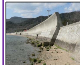
津波、高潮による被害を未然に防ぐため海岸堤防の整備を推進
