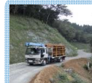
幹線となる道の整備
