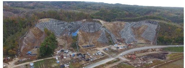
平成30年北海道胆振東部地震の災害復旧状況（北海道）
