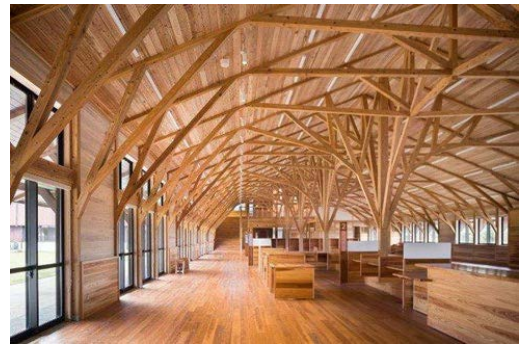
「令和元年度木材利用優良施設コンクール」 内閣総理大臣賞 屋久島町庁舎（鹿児島県屋久島町） 「ウッドデザイン賞2019」優秀賞（林野庁長官賞）
