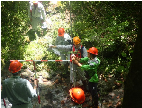
治山施設設計のための現地調査の様子
