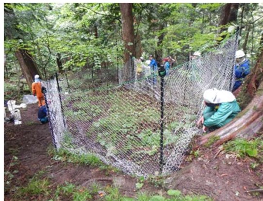
コアツモリソウ生育地での 防護柵のネット張りの様子
