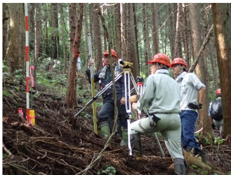
林道作設のための測量実習の様子
