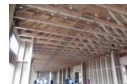
製材による大規模トラス
