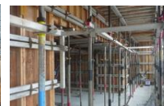
実証施工の様子
