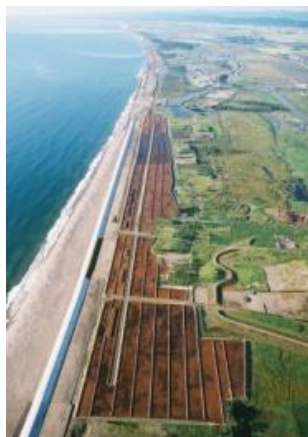
〔 生育基盤の整備のための盛土工事 〕
