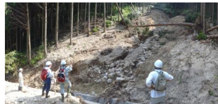
集中豪雨により被災した民有林の 災害復旧調査を支援
