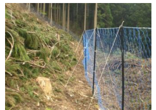
防護柵による被害の防除
