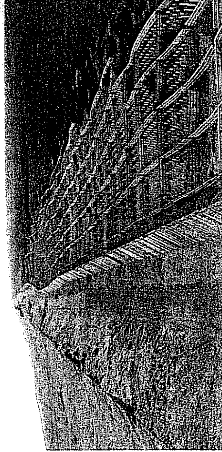
場所：青森県北津軽郡市浦村 五月女 まごめやち 菟国有林 (津軽森林管理署金木支署管内) 説明：写真は、スギ間伐材を利用した防風柵、静砂垣と植栽されたクロマツの様子です。
