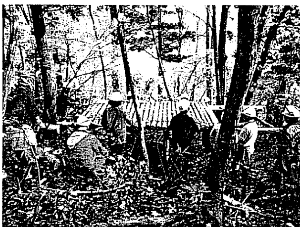
自然学校で見晴台を造っている様子
