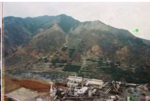
施工状況(施工中)(S54)
