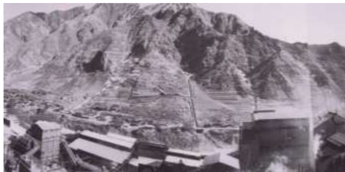
荒廃状況(施工前)(S45頃)
