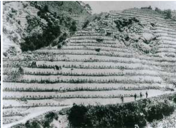
施工1年目の再度山(明治37年)
