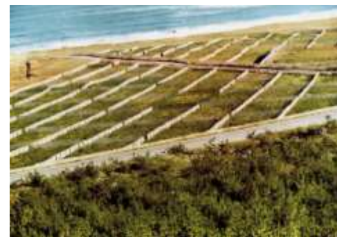
防風柵の設置状況(S46)
