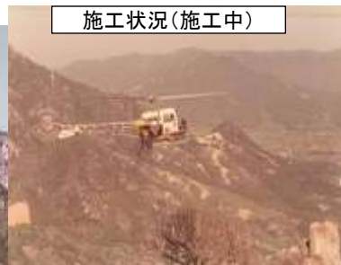
施工状況(施工中)
