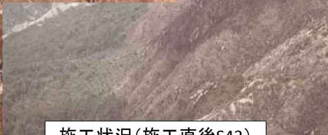
施工状況(施工直後S43)
