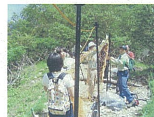
防護柵の設置
