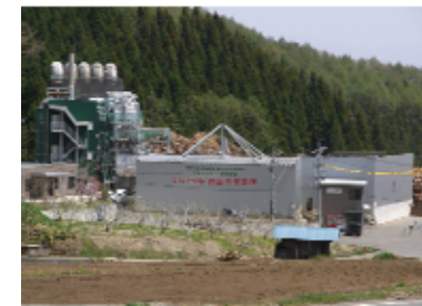
木質バイオマス発電所
