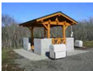
改修後の炊事場
