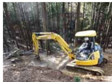
丈夫で簡易な作業道の整備
