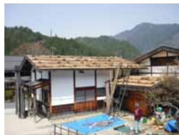
屋根の葺き替え作業
