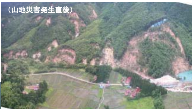
（地すべり防止工事施工中）
