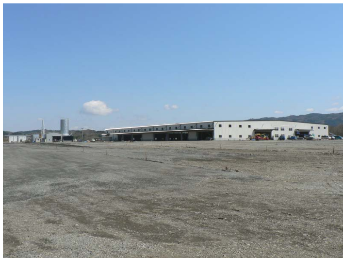
協和木材(株)建設中の新工場(平成18年4月28日現在)
