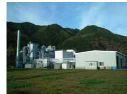
バイオマス発電施設
