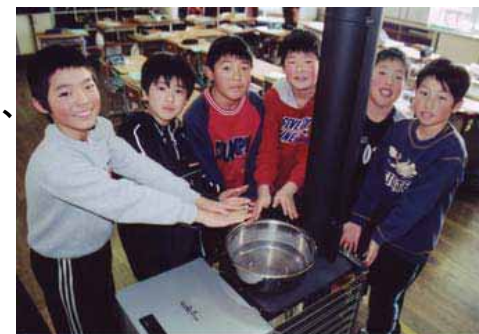
小学校に導入されたペレットストーブ
