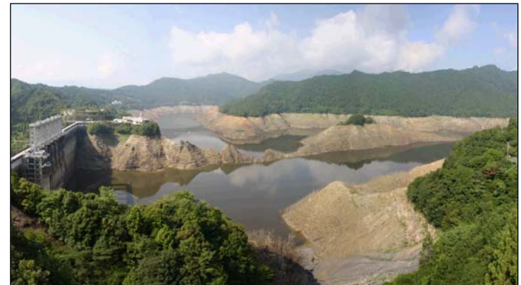
写真：高知県・早明浦ダム（平成17年9月撮影）
