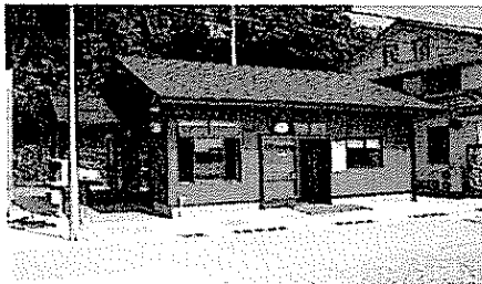
三重県鳥羽市 定期船待合所 （新漁村コミュニティー基盤整備事業）
