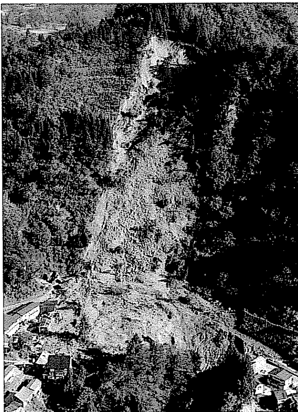
山腹崩壊により県道および住宅が被災した。(新潟県山古志村竹沢)
