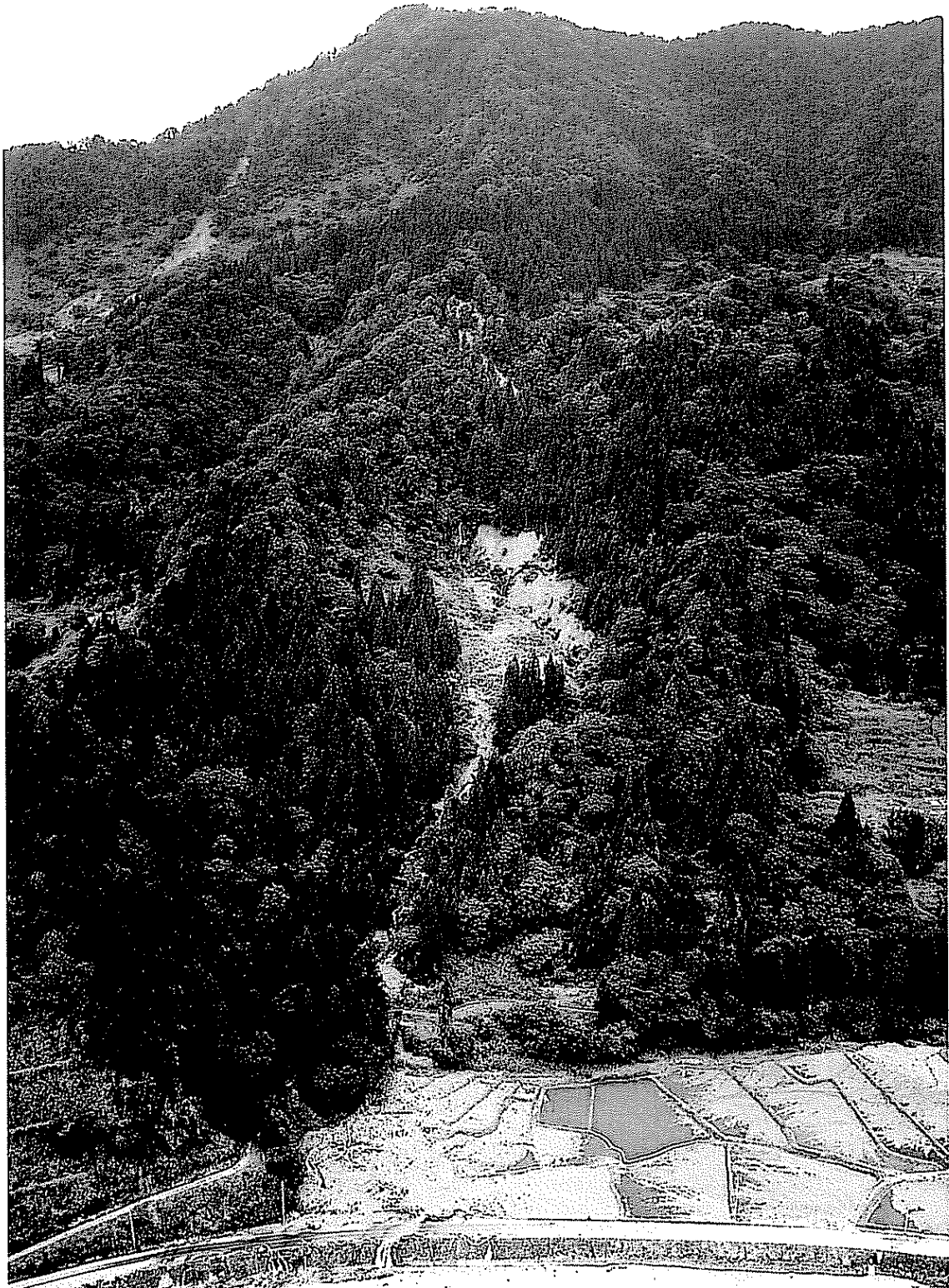
栃尾市では7月13日、日降水量が421ミリに達した結果、谷筋の林地が崩壊し、土石流が発生。水田、県道二分栃尾線、刈谷田川（1級河川）が土砂で埋めつくされた。 （新潟県栃尾市）
