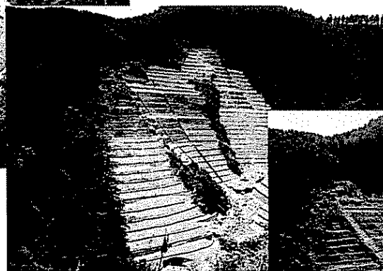
2. 山腹の基礎工事に着手 崩壊地を安定させるための土留工、水路工を設置するとともに筋工、緑化工を施工。
