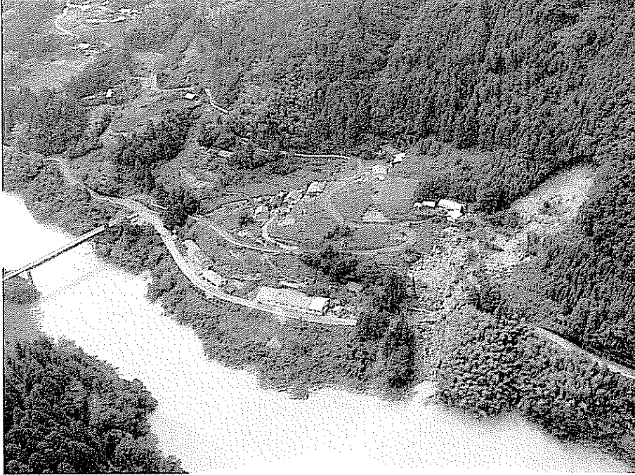
豪雨の影響を受け、10年生のヒノキが生育している山腹が幅30メートル、深さ1メートルにわたり崩壊し、下を走る道路を埋めつくした。 (高知県土佐町)
