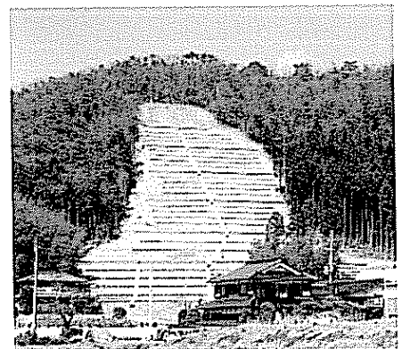
↑山腹工により復旧（兵庫県）
