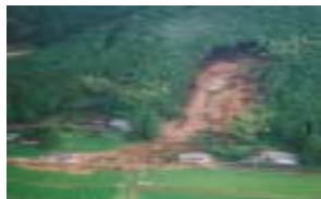
脆弱な地盤と豪雨による山崩れ(昨年7月梅雨前線豪雨災害(鹿児島県菱刈町))
