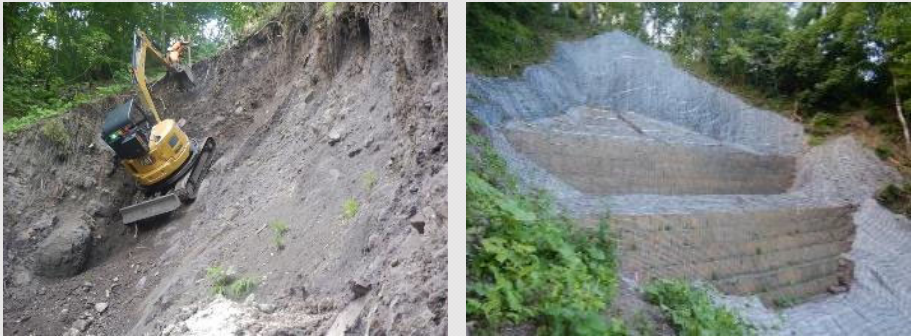
・秋田県仙北市 湯前山国有林 ・(左)セーフティークライマー工法(令和 7 (2025) 年 6 月) (右)完成写真(令和 7 (2025) 年 8 月)
