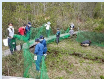
湿原を保全するための防護柵の設置
