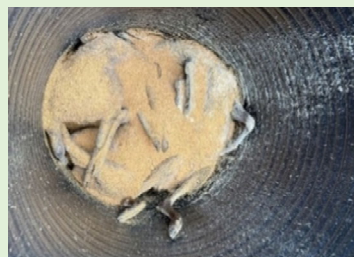
大型排水管内部の様子
