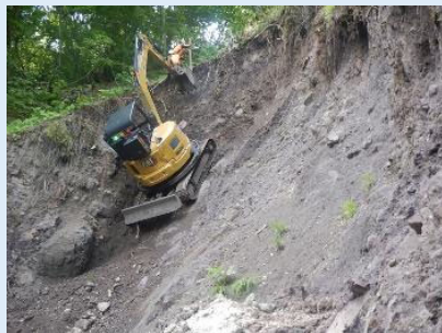
セーフティークライマー工法 (秋田県仙北市:令和7(2025)年6月)
