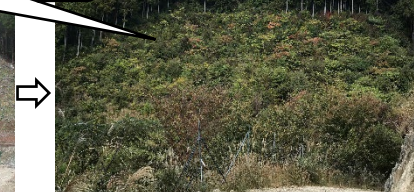
防護柵設置後
