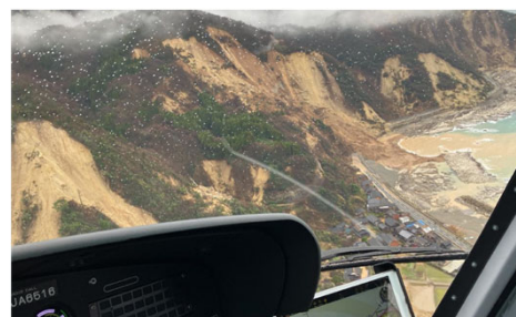
1/21 大規模崩壊地の確認
