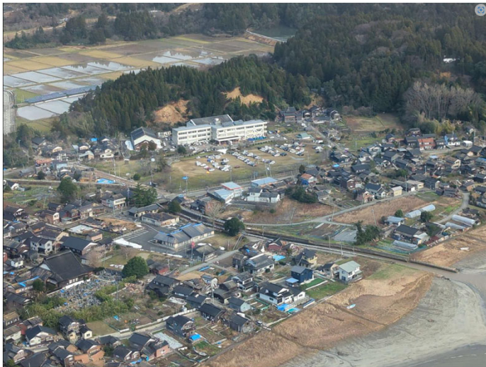
学校の裏山崩壊（珠洲市）
