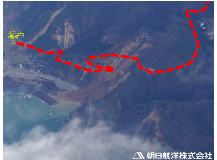
山腹崩壊による林道の崩落（珠洲市）
