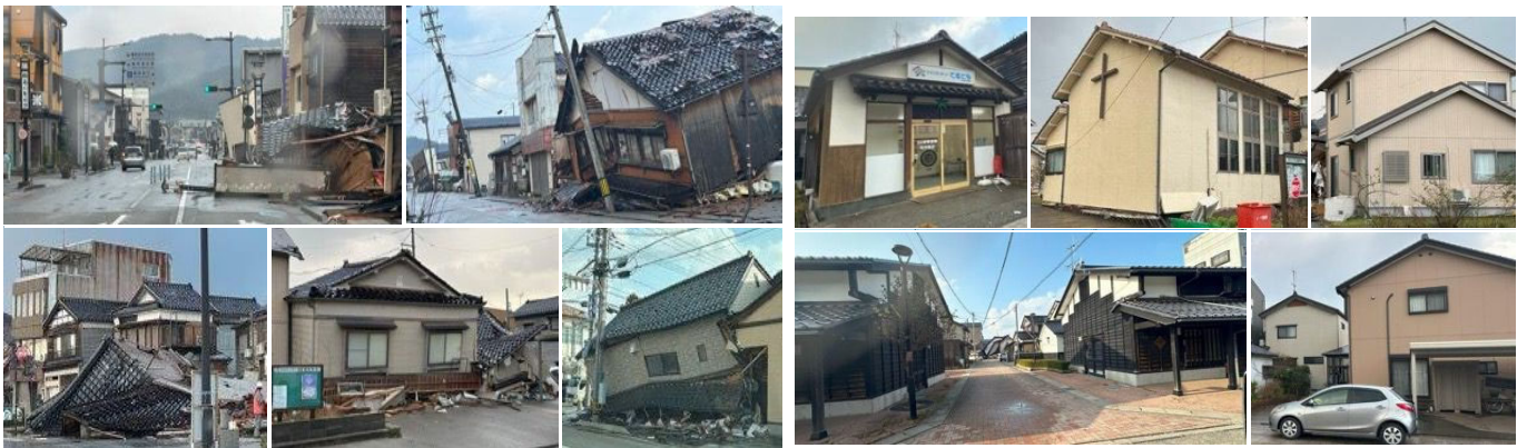
倒壊家屋の写真
