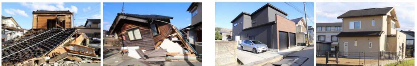
倒壊した建物
