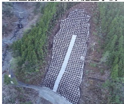
山腹工 (令和4年3月 高知県馬路村)
