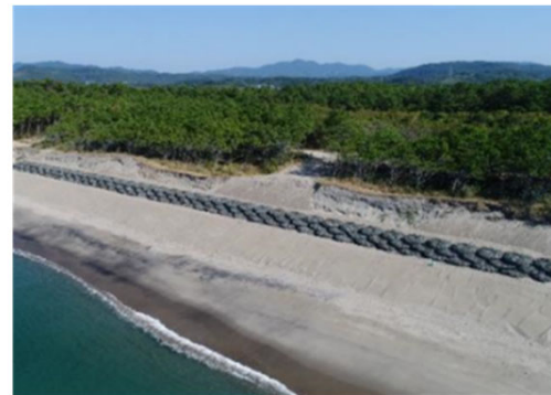
防潮工 (令和3年3月 鹿児島県いちき串木野市)
