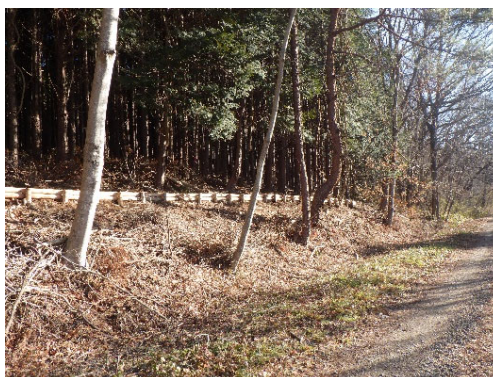
里山再生事業による除伐及び丸太筋工
