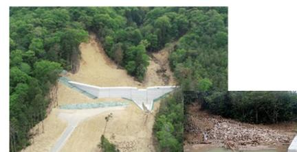
令和3年8月の大雨における治山ダムによる土砂の流出抑制
