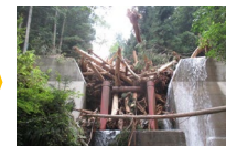
流木捕捉式治山ダム整備による流木等の捕捉
