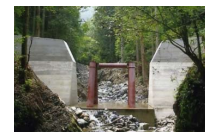
流木捕捉式治山ダム整備による流木等の捕捉
