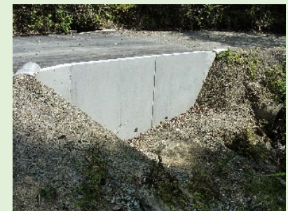
完成後の擁壁工
