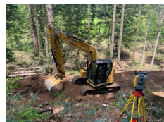
MC(マシンコントロール)バックホウによる掘削
