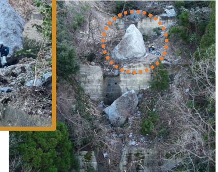
石川県輪島市 令和6年能登半島地震において、 階段状に設置した治山ダムが巨石等を捕捉
