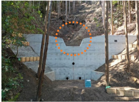
令和4年台風第15号において、治山ダムが土砂を捕捉
