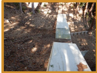
令和4年台風第15号において、治山ダムが土砂を捕捉
